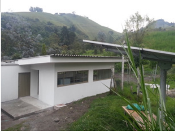
Figura 19. Módulo solar para energía ambiente de aprendizaje
