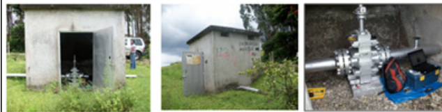
Figura 28. Vistas de la Caseta (Fuente: Autores)
